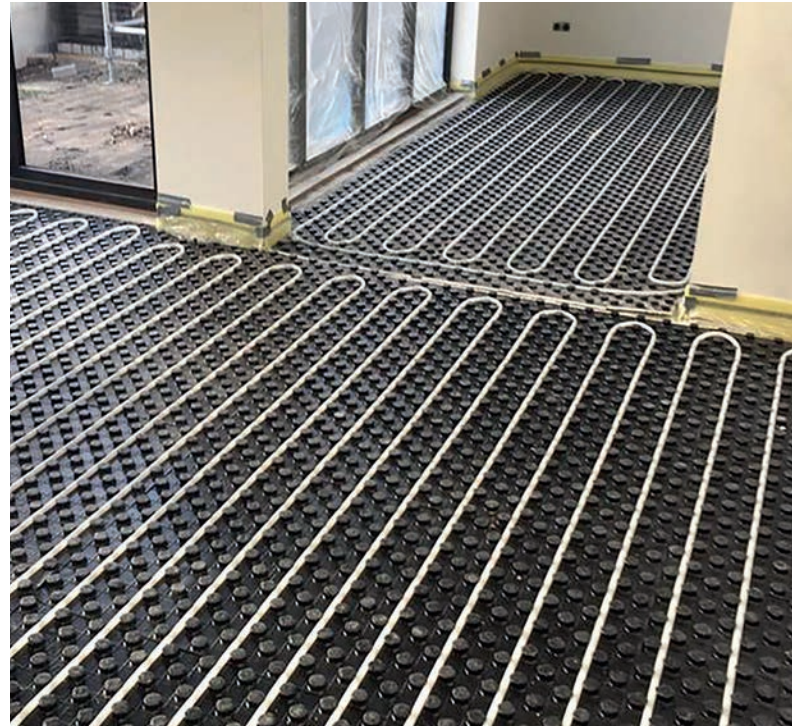
Breda Niederlande ▲ Fußbodenheizung
