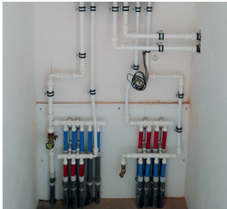
▲ Steekkoppelingen, België Henco Visioninstallatie voor sanitair
