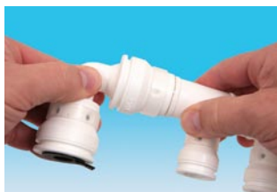
Insérez le coude d'alimentation de 90° dans le collecteur.
