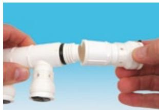
Gerades IG Doppelfitting mit dem Verteiler verschrauben.
