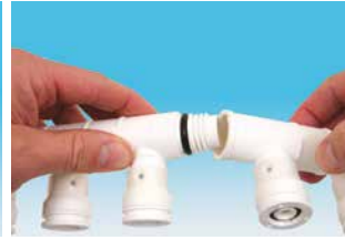
Spojiti nastavak sa razdelnikom.
