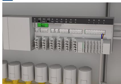
Connectez les actionneurs aux zones via les bornes sans vis.
