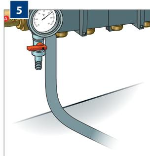
**Posez la conduite.** Évitez la tension sur le distributeur en réalisant **une courbe perpendiculaire** mais fluide.
