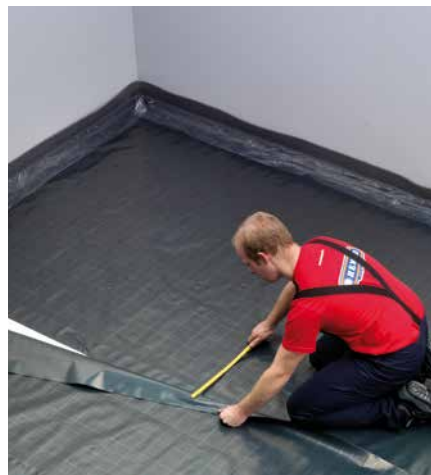
De PE folie wordt 15 cm overlappend aangebracht.
