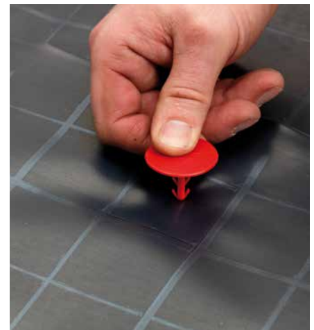
Indien gewenst kan er een folienagel aangebracht worden. Dit voorkomt het verschuiven van de folie tijdens de werkzaamheden.
