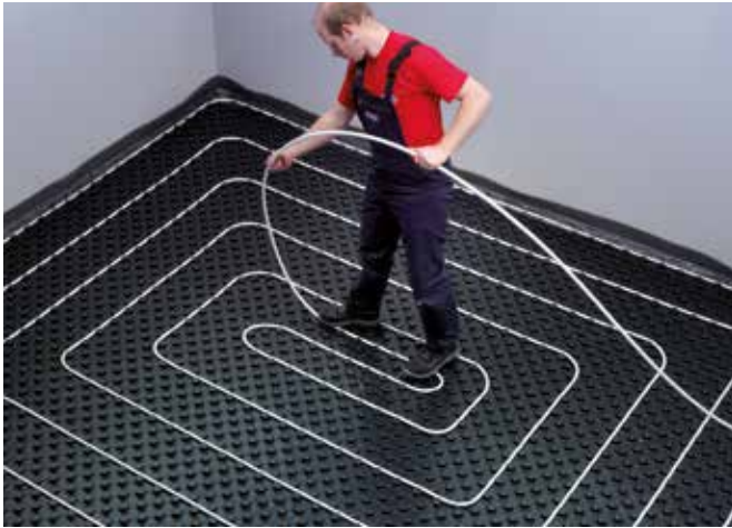
Das Rohr wird spiralförmig verlegt.
