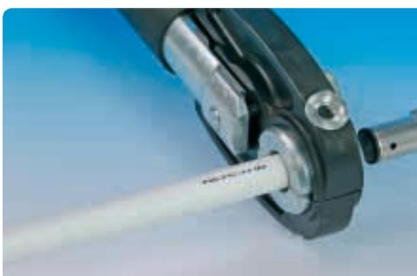
Après le sertissage, ouvrez la mâchoire à sertir et contrôlez si le tube est toujours monté jusqu'à la butée, afin que les regards aient totalement pris la couleur du tube.
