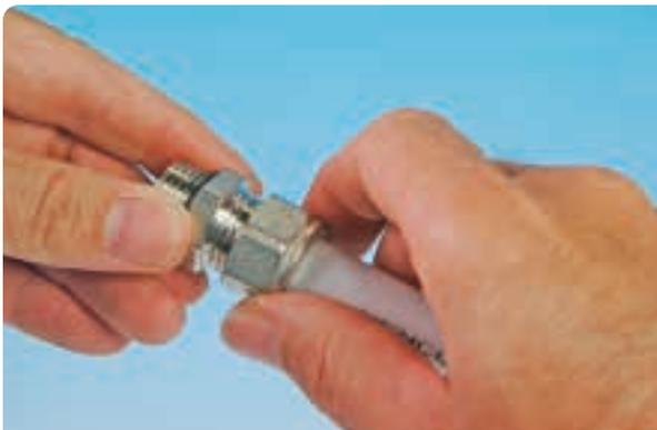
Maintenant, tournez l'écrou sur le filetage extérieur du nipple, du robinet, du collecteur, etc.
