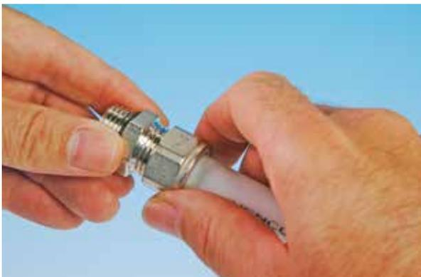
Ziehen Sie die Mutter am Nippel, Hahn oder Heizkreisverteiler an. Das Anziehen sollte immer mit Hilfe von zwei Maulschlüsseln erfolgen, bis Sie das vom Hersteller vorgeschriebene Anzugsmoment gemäß der folgenden Tabelle erreicht haben.
