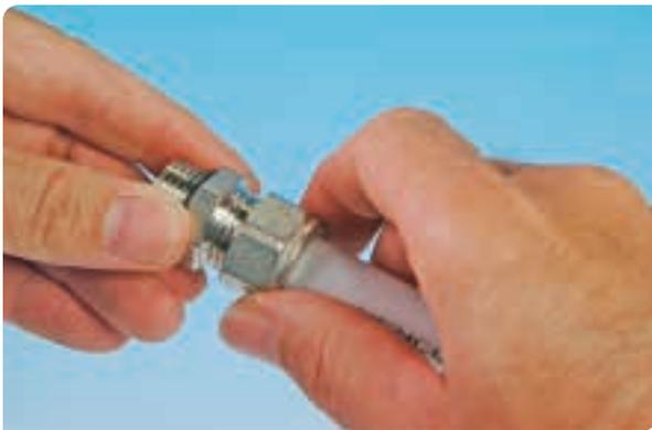
Ziehen Sie die Mutter am Nippel, Hahn oder Heizkreisverteiler an.
